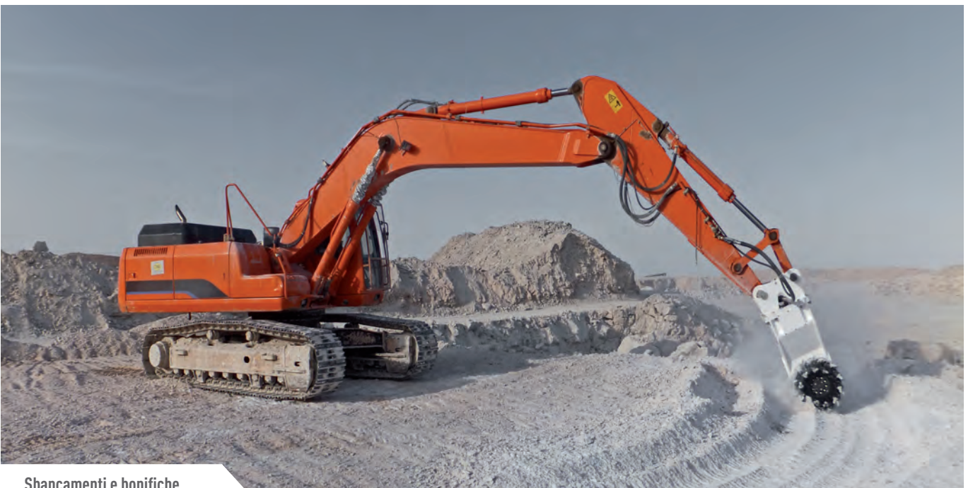
Sbancamenti e bonifiche
